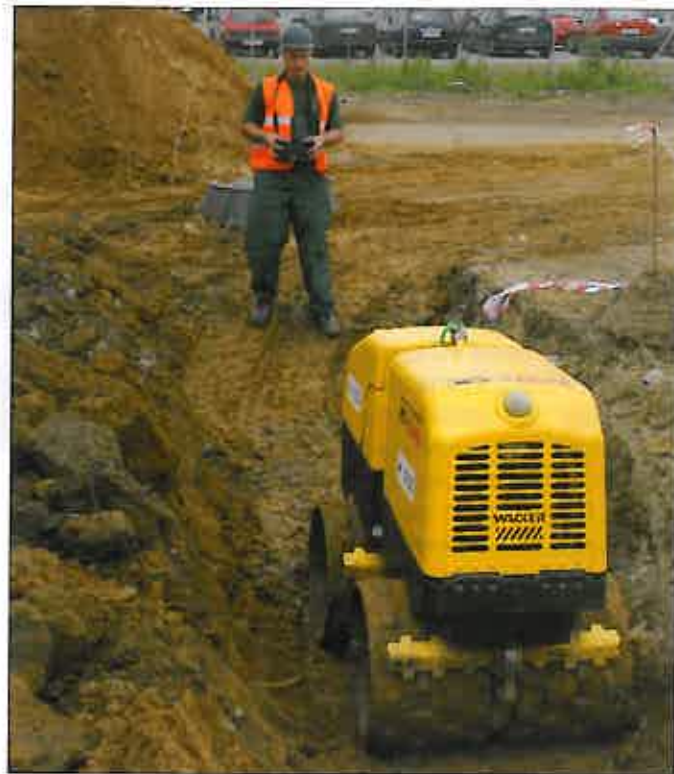
Po krótkim przeszkoleniu obsługa walca nie sprawia żadnych trudności. Operator jest w stanie pracować szybko, bezpiecznie i co najważniejsze efektywnie
