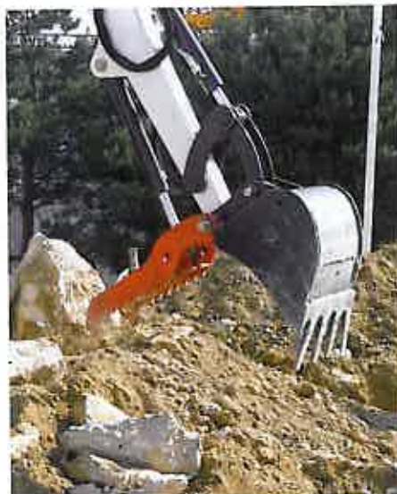
La E55W a une profondeur de fouille maximum de 3495 mm le site de travail.
