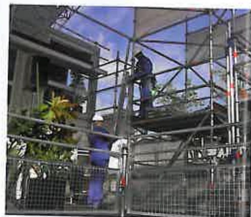
Les compagnons Layher simulent une opération mettant en scène la trappe amovible, sur laquelle se tient le technicien au harnais vert.
