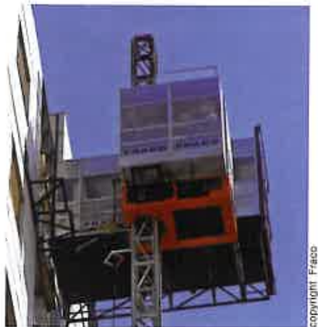
Son mat est caractérisé d'unique, fixé par ancrage à intervalles de 9,10 m
